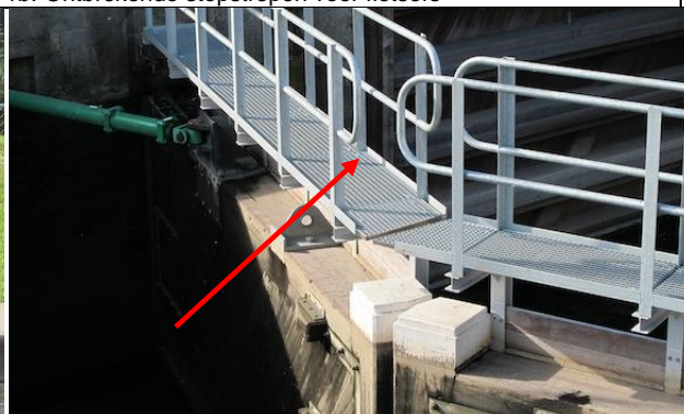
3a. Aansluiting hekwerk sluisdeur
