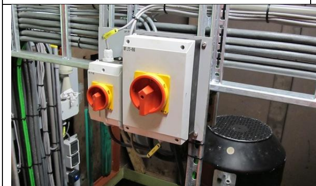
4. Werkschakelaars zijn niet gecodeerd
