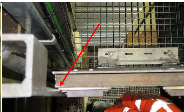
2. Toegang naar 1 o niveau is niet afgesloten met kantelbaar rooster
