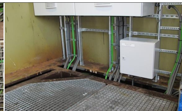
6b. Bordes oude schakelkasten niet voorzien van roosters
