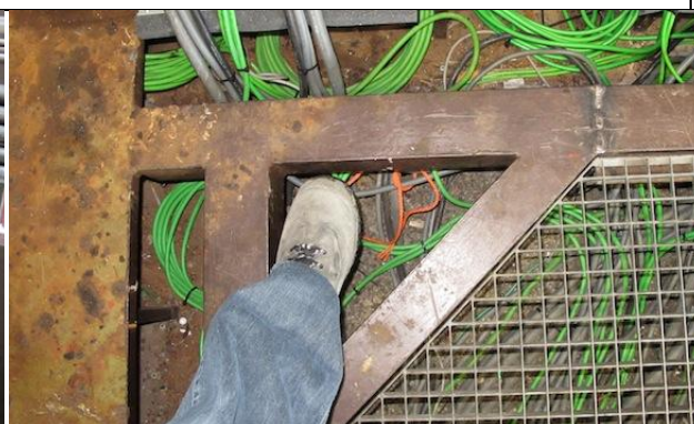
6a. Bordes oude schakelkasten niet voorzien van roosters
